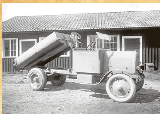
En bevarad lastbil av märket Tidaholm från 1923. Notera trissorna till tippen. Notera också att bilen har luftfyllda hjul, vilket inte var självklart på den tiden. Foto: Tidaholms museum
